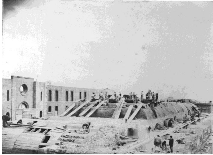
Otra: ha avanzado el alzado de la iglesia. Bóvedas de los Pabellones donde residirían los soldados.
