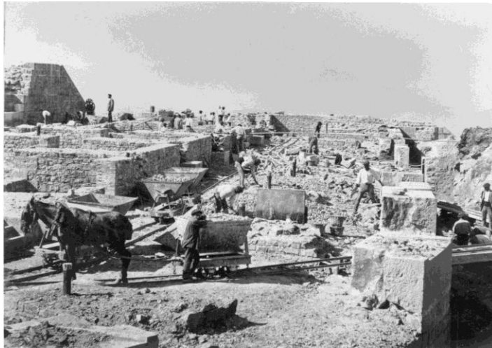
Otra foto de las obras.
