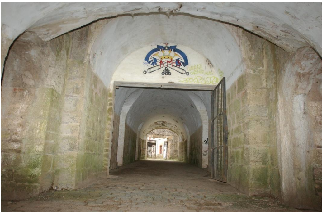
Túnel de rastrillos.
