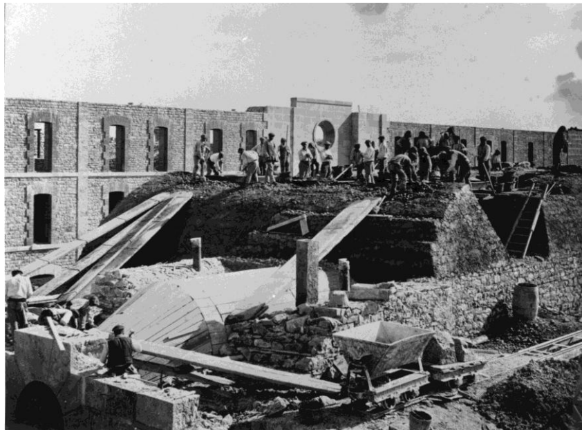
Bóvedas y cubierta de los Pabellones e iglesia.
