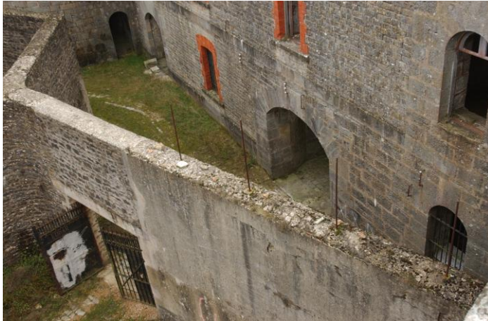
Puerta del patio y puerta del túnel de rastrillos.
