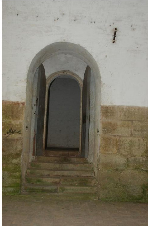
Una celda de castigo situada en el túnel de rastrillos.
